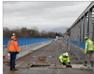
Les travaux de finition de la passerelle cycliste du Grand Canal et du Rhin entre Chalampé et Neuenburg seront terminés le 15 avril. Photo L'Alsace/Darek SZUSTER
